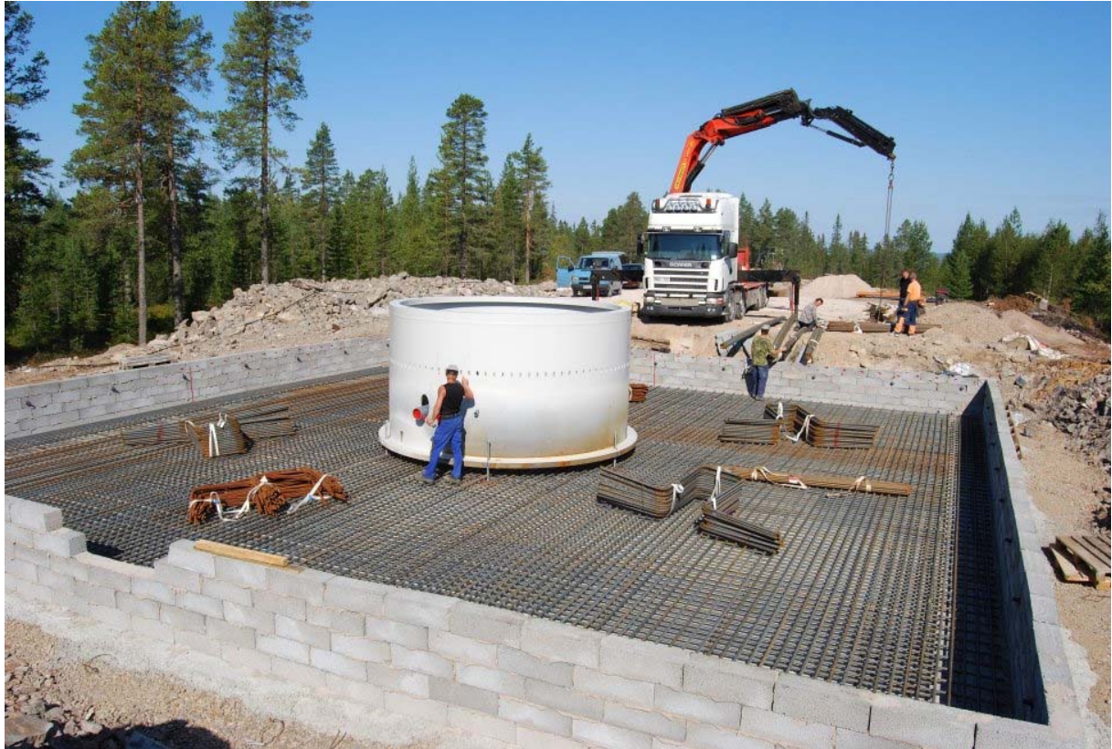
PROJEKT BYRÅSEN - Armering av fundament
