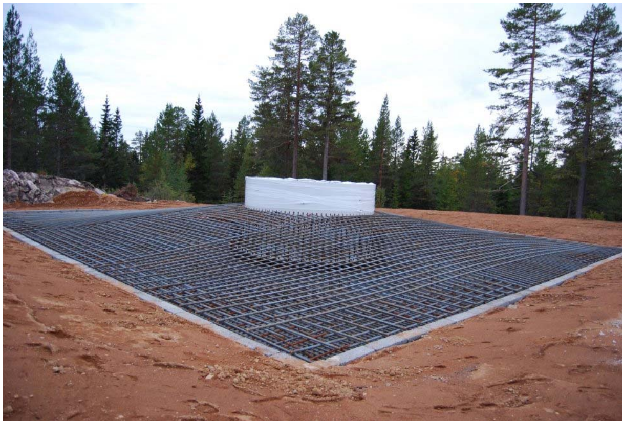
PROJEKT BYRÅSEN - Armering av fundamentet före gjutning
